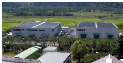
第7工場・第8工場 太陽光発電設置
